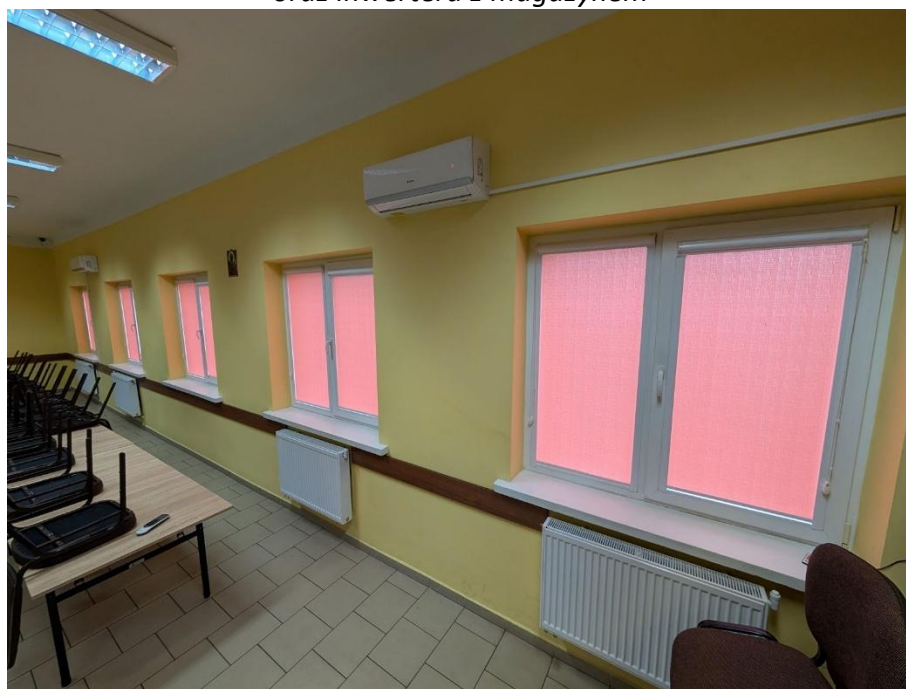
Rysunek 3.10 Grzejniki aluminiowe ścienne w sali głównej obiektu
