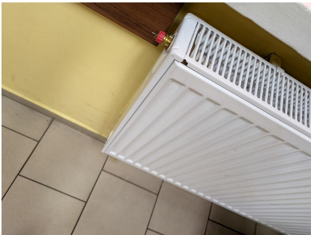
Rysunek 3.11 Zawór grzejnikowy bez głowicy termostaticznej
