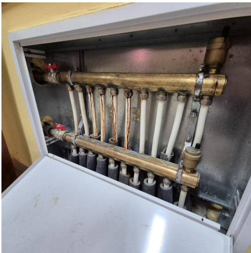
Rysunek 3.13 Istniejący zespół rozdzielaczy czynnika grzewczego do grzejników obiektu
